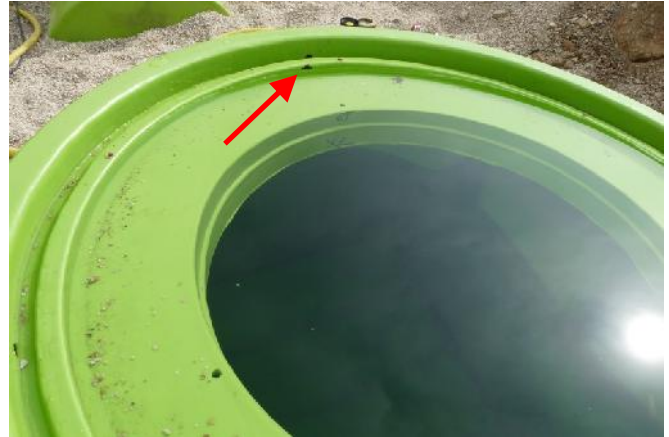
Bild 8: Wasserfüllung bis Höhenmarke am XL
