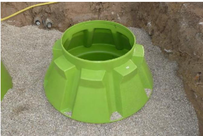
Bild 3: Schacht MEDIUM beim Einbau
