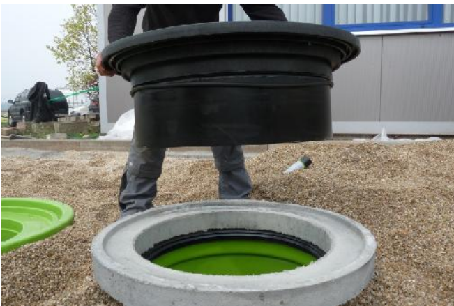
Bild 11: Abdeckung EASY, Dichtung, Betonring, Teleskop-Schachtverlängerung, Deckel
